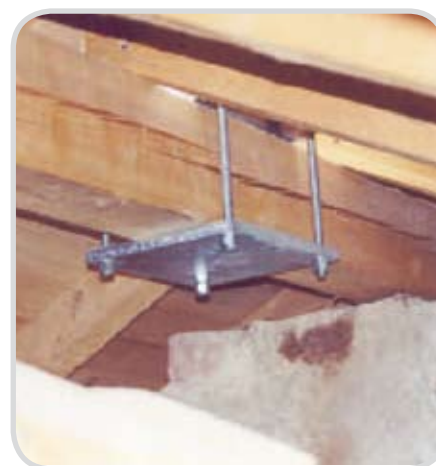
Installazione con contropiastra
