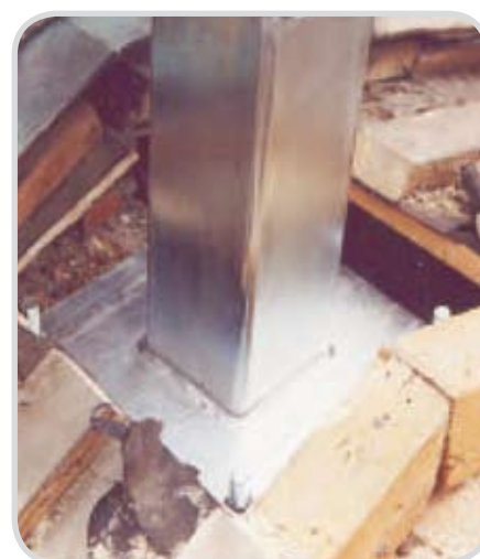
Installazione paletto su trave di colmo
